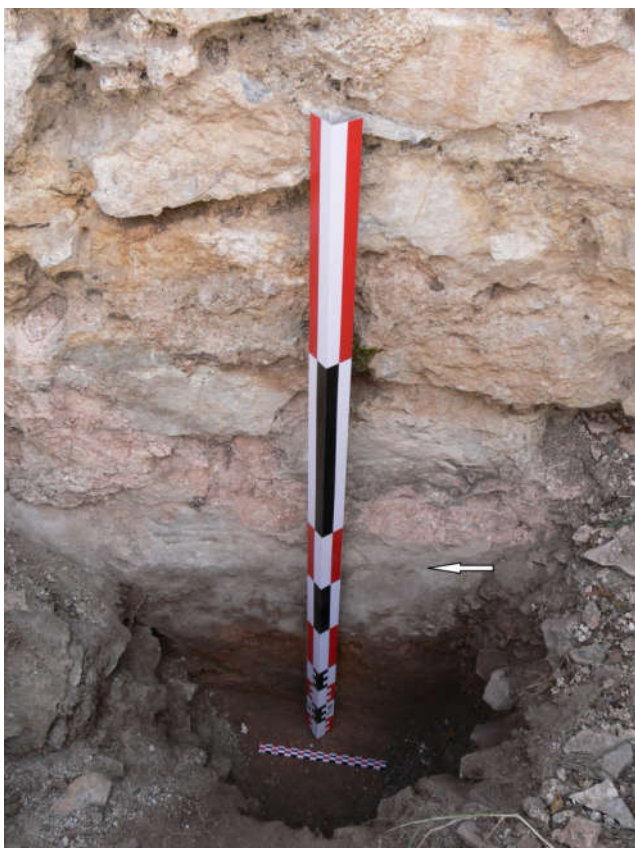
Fig. 32-detaje të llaçit hidroizolues të sterës.
